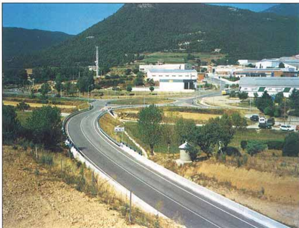
Vispa parcial de la rotonda en el polígono de "La Valldan".
