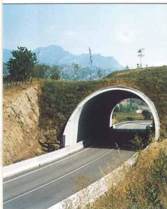
Boca "La Vallan" y boca de "Berga" del falso túnel.
