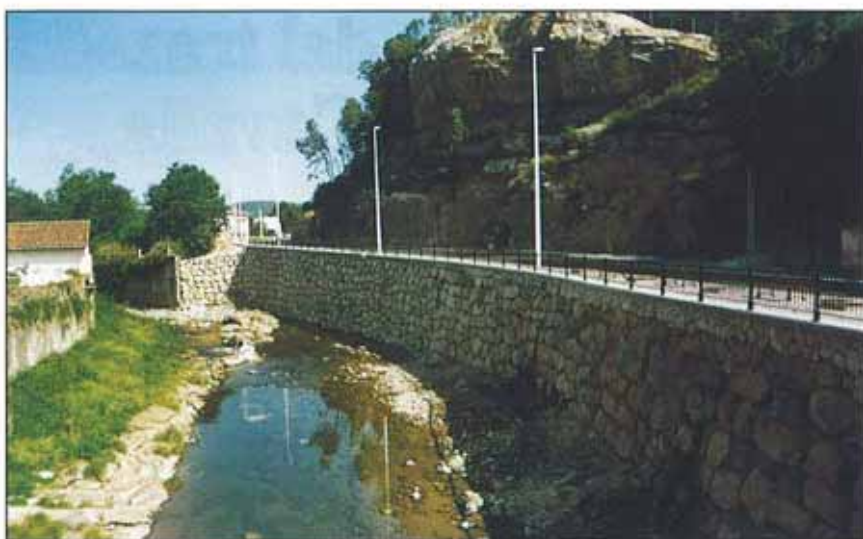
Muro de apoyo de piedra.
