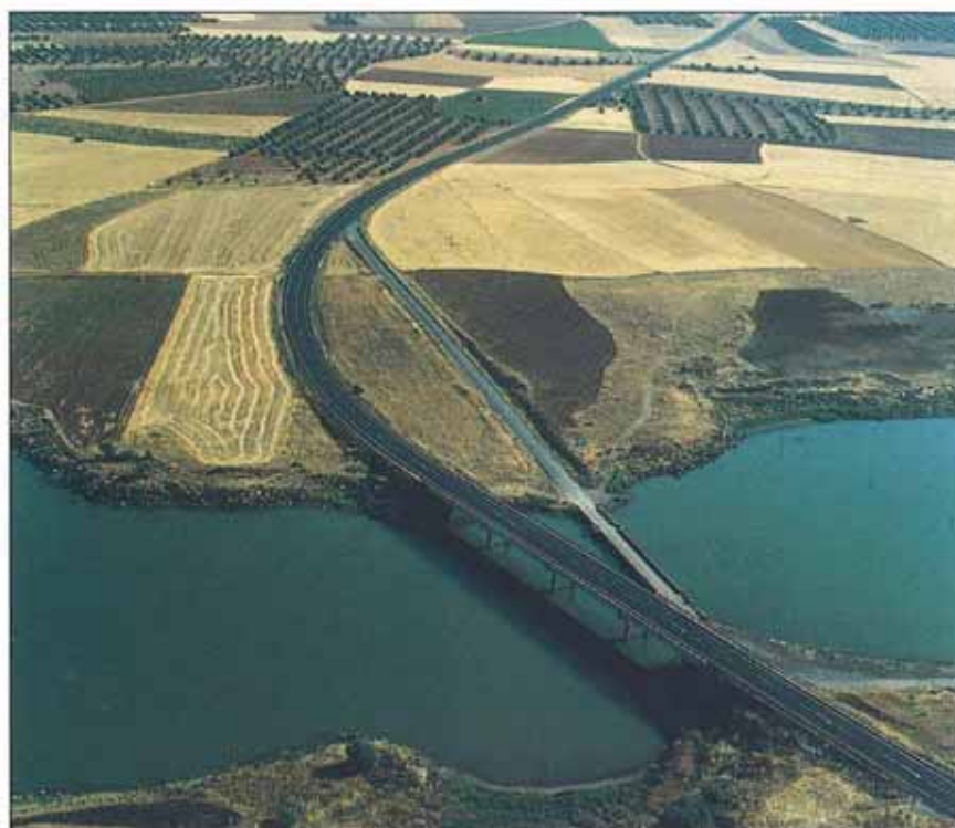
Puente sobre el río Jabalón.
