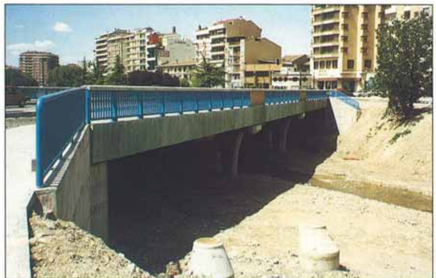
Puente sobre el río Sosa con tableros de vigas prefabricadas de 60 cm de canto.
