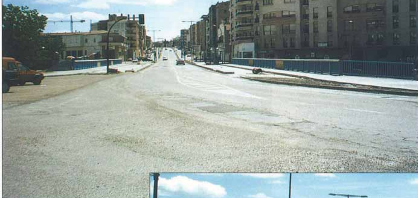
Vista panorámica de la obra y de la nueva travesía.
