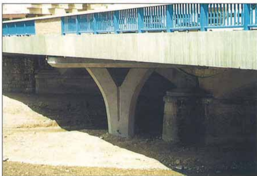
Detalle de las pilas del nuevo puente sobre el río Sosa.
