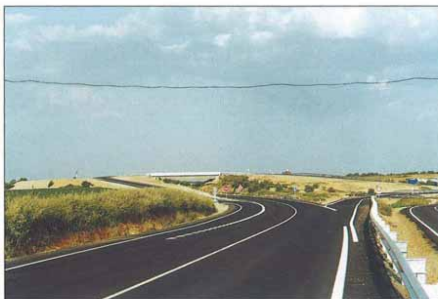
La obra desde otra perspectiva.
