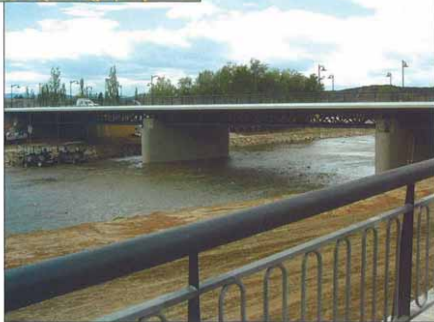
El puente sobre el río Cidacos desde otra perspectiva.
