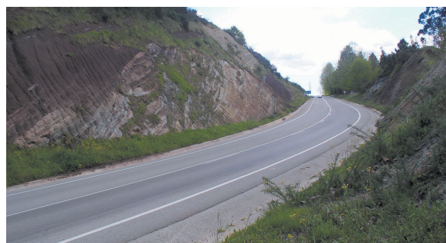
Foto 2. Desmorte izquierdo previa la realización de la hidrosiembra (2 mayo 2007).
