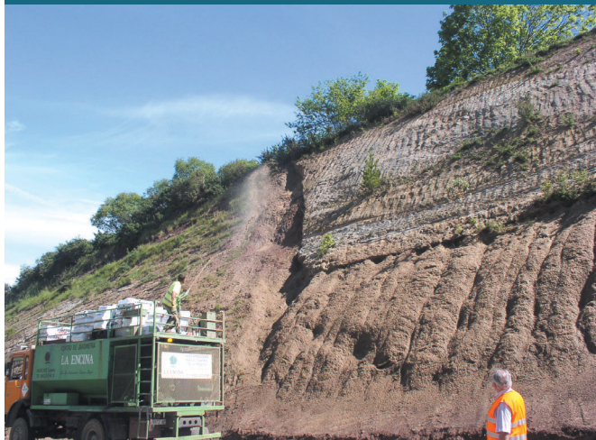
Foto 38. Sector IV siendo hidrosembrado el 18/05/2007.
