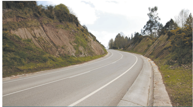
Foto 8. Aspecto del talud derecho, a 02.04.2008
