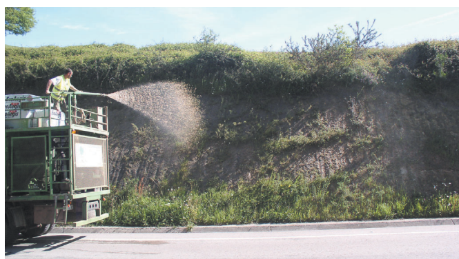
Fotos 3 y 4. Trabajos de proyección de sustrato e hidrosiembra.
