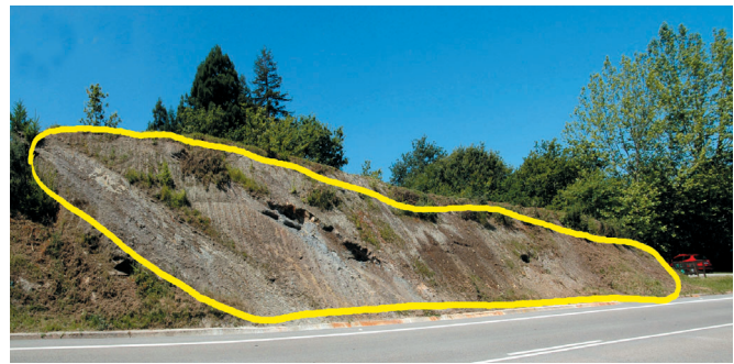
Talud izquierdo-Sector IVb (foto 22)
