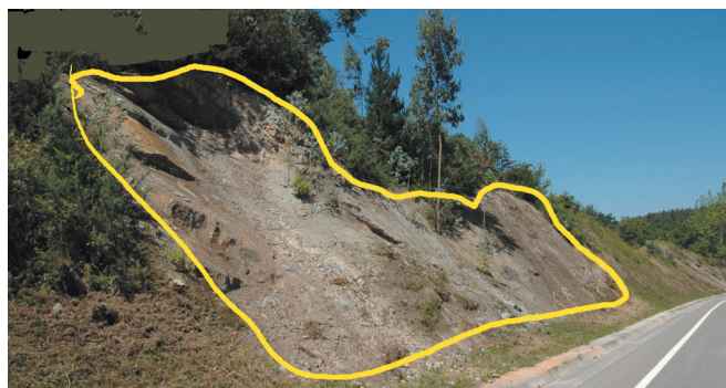
Talud izquierdo-Sector IIb (foto 20)
