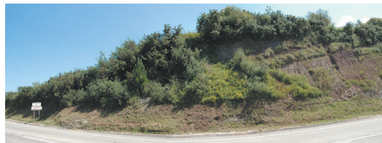
Foto 9. Aspecto del talud derecho, a 10.07.2008.
