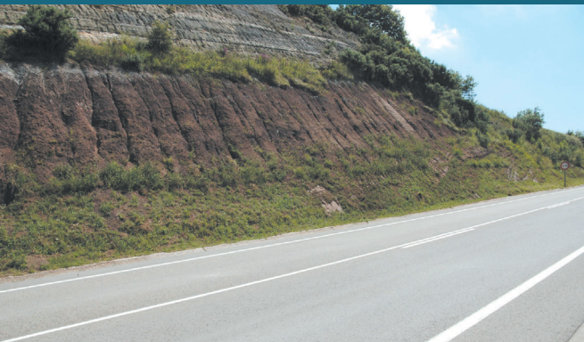
Foto 42. Pie del talud derecho donde se observa la banda de vegetación característica de estos taludes.
