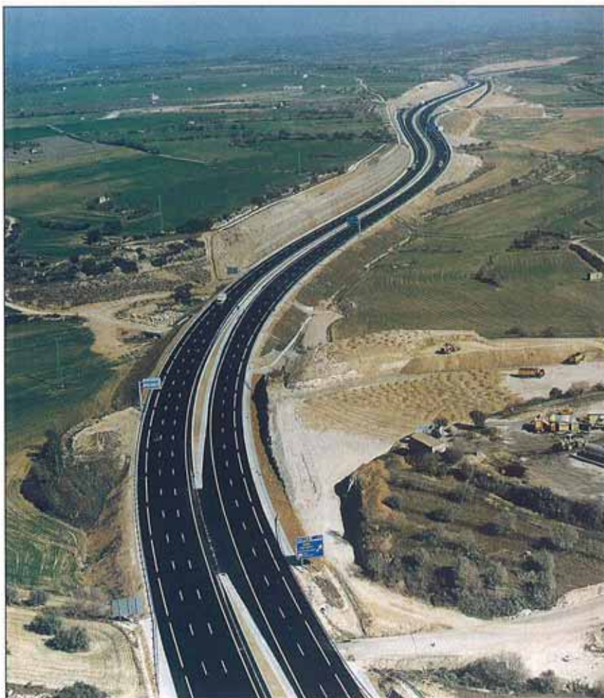
El trazado tiene una longitud de 6 840 m con características de autovía.
