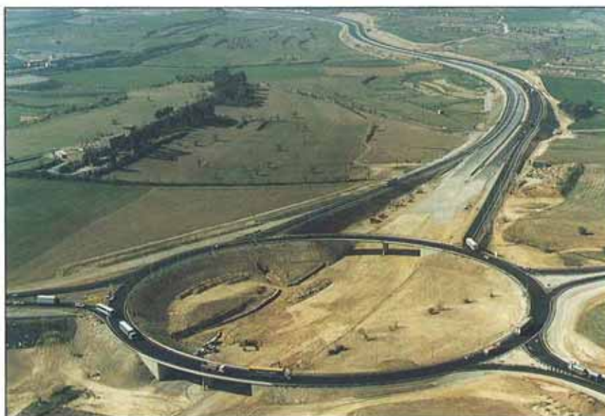
Enlace de Cervera Este, anillo circular de 200 m de diámetro. El tramo siguiente de autovía dará continuidad a las calzadas centrales.
