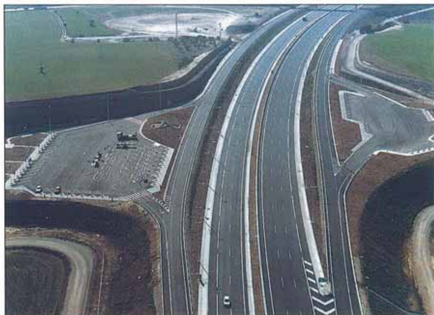
El radio mínimo en planta es de 800 m y la pendiente máxima del 4,5%.
