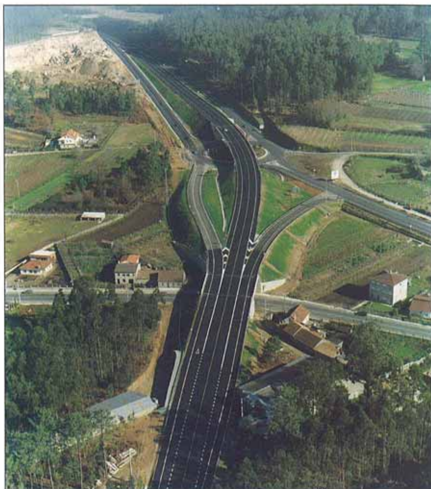
El nuevo tramo fue puesto en servicio el 28 de diciembre de 1999 y tiene características de vía rápida.
