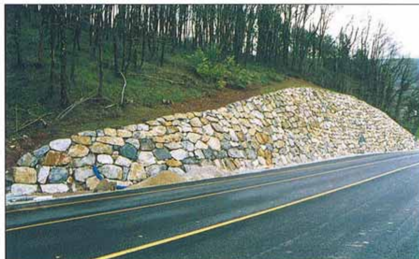
Muro de escollera para la contención de la ladera.
