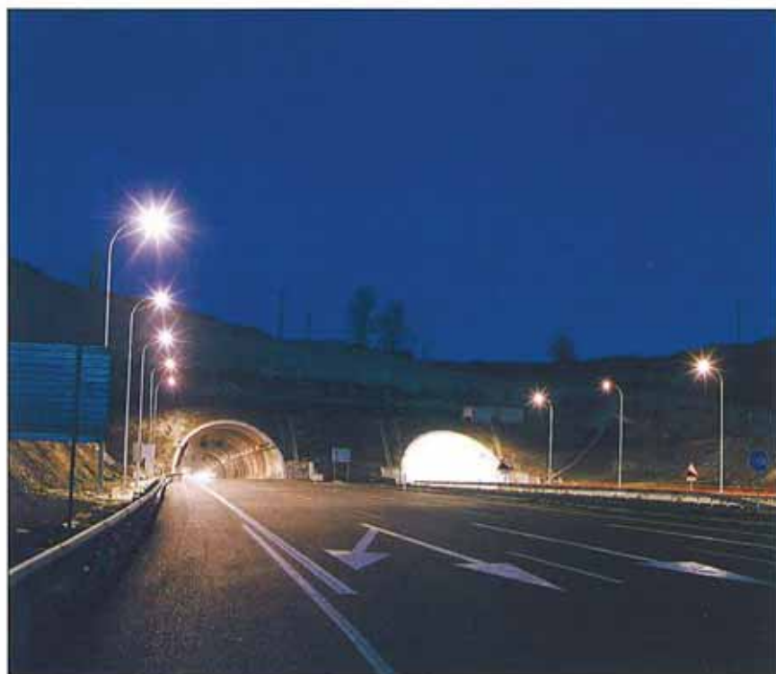
Túneles de Padornelo.
