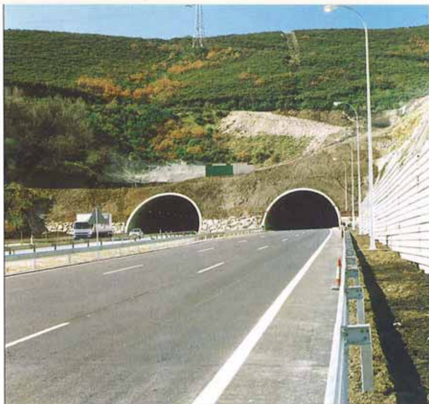
Túneles de la Canda.
