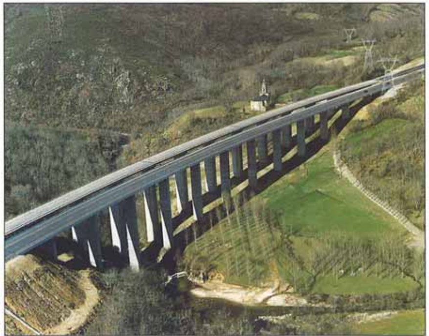
Vista aérea del viaducto sobre el río Tuela.
