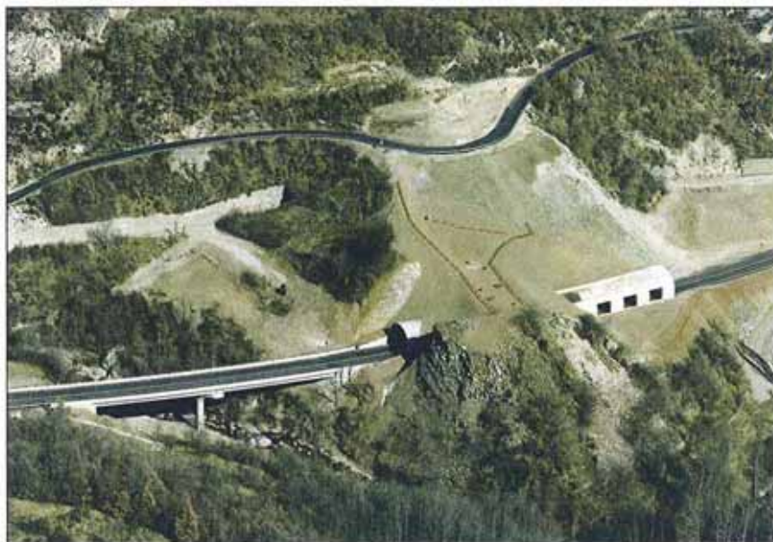
Vista panorámica del túnel de Bellera, del tramo Senterada-Xerallo.
