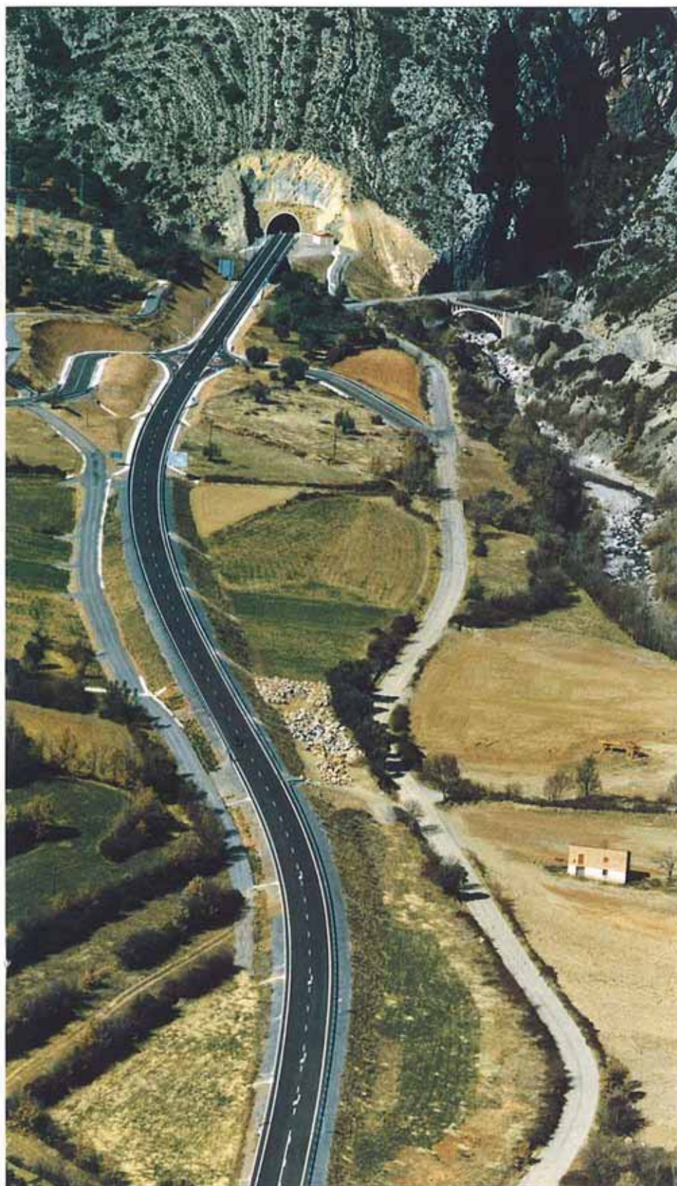
Vista parcial del tramo La Poblá de Segur-Senterada
