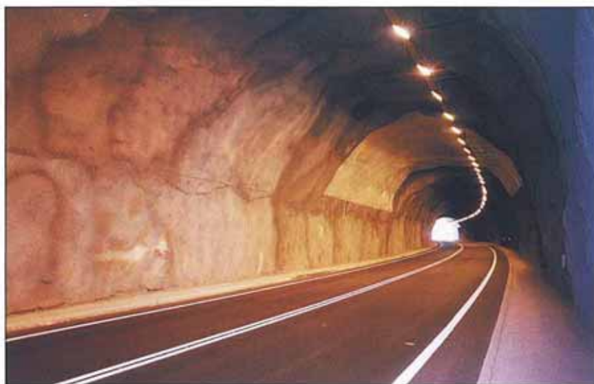
Interior del túnel de Cartanís.
