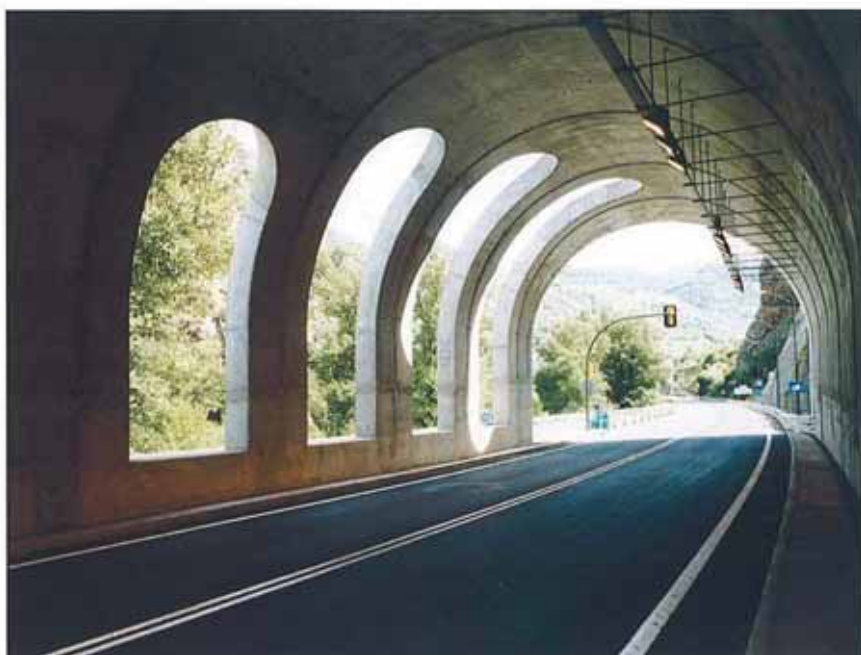
Vista del interior del túnel de Arboló.
