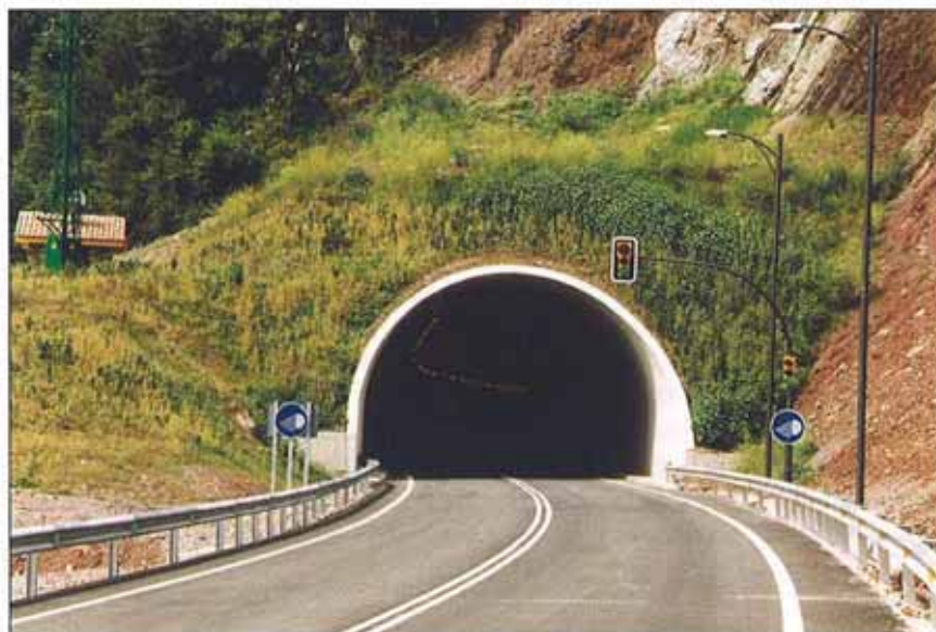
Entrada del túnel de Cartanís, tramo La Pobra de Segur-Sort.
