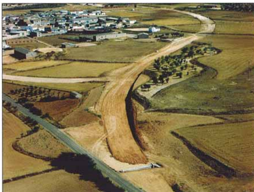
Vista panorámica del tramo en construcción y en fase de explanación.
