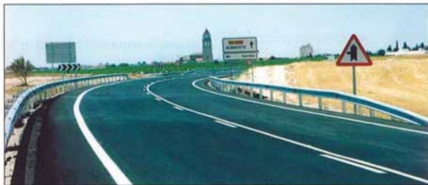
Vista del tramo finalizado.
