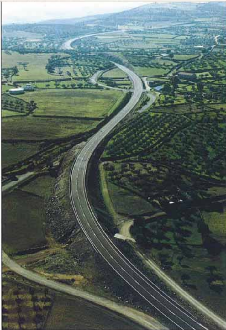
Vista parcial de la nueva carretera.
