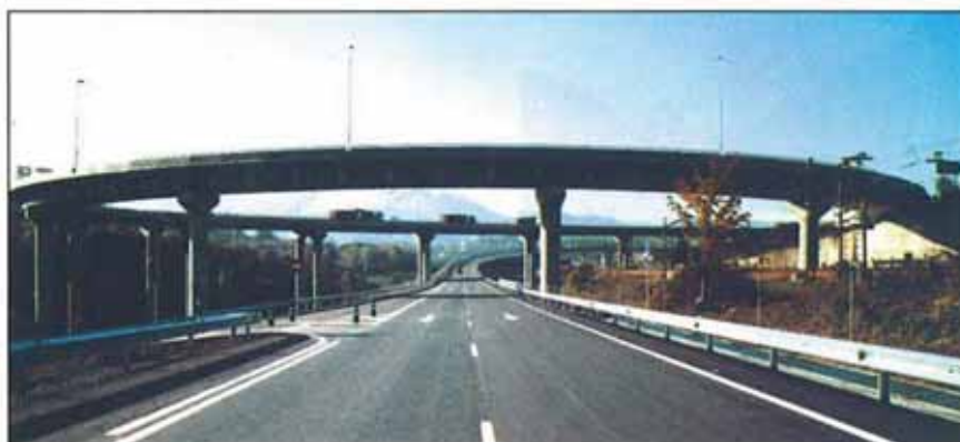
Vista parcial de las obras de fábrica 3A y 3B.
