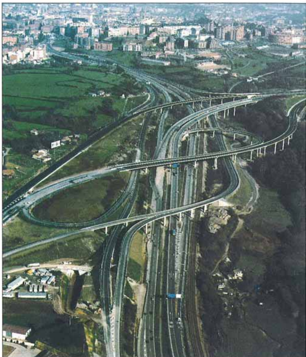
Vista panorámica del enlace de tipo trébol parcial esviado a tres niveles de El Cueto que, como se aprecia en la imagen, tiene un diseño vistoso y singular.
