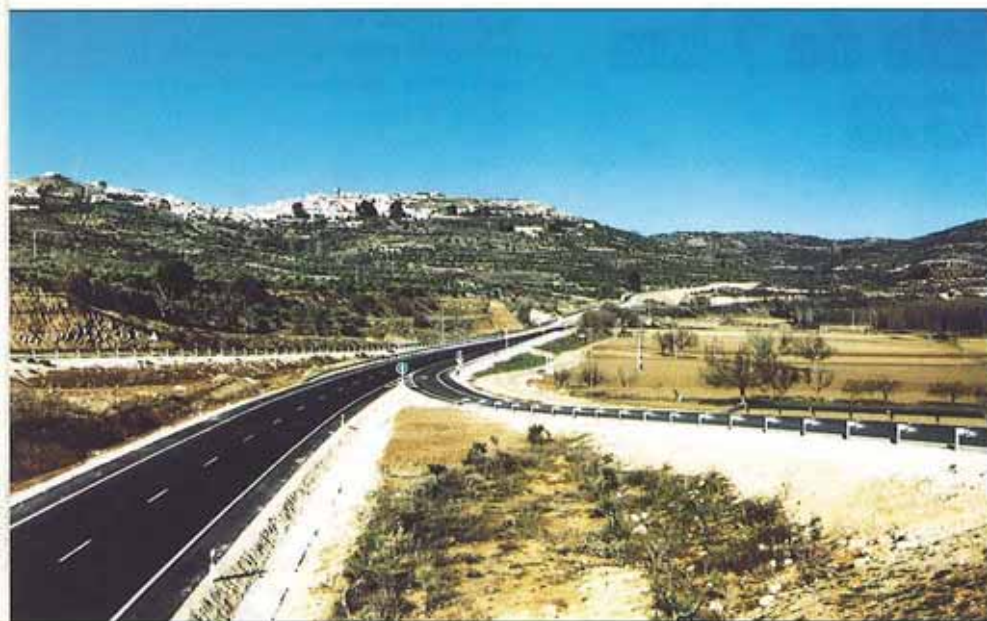
La sección transversal se compone de dos carriles de 3,5 m de anchura y arcenes de 1,5 m.
