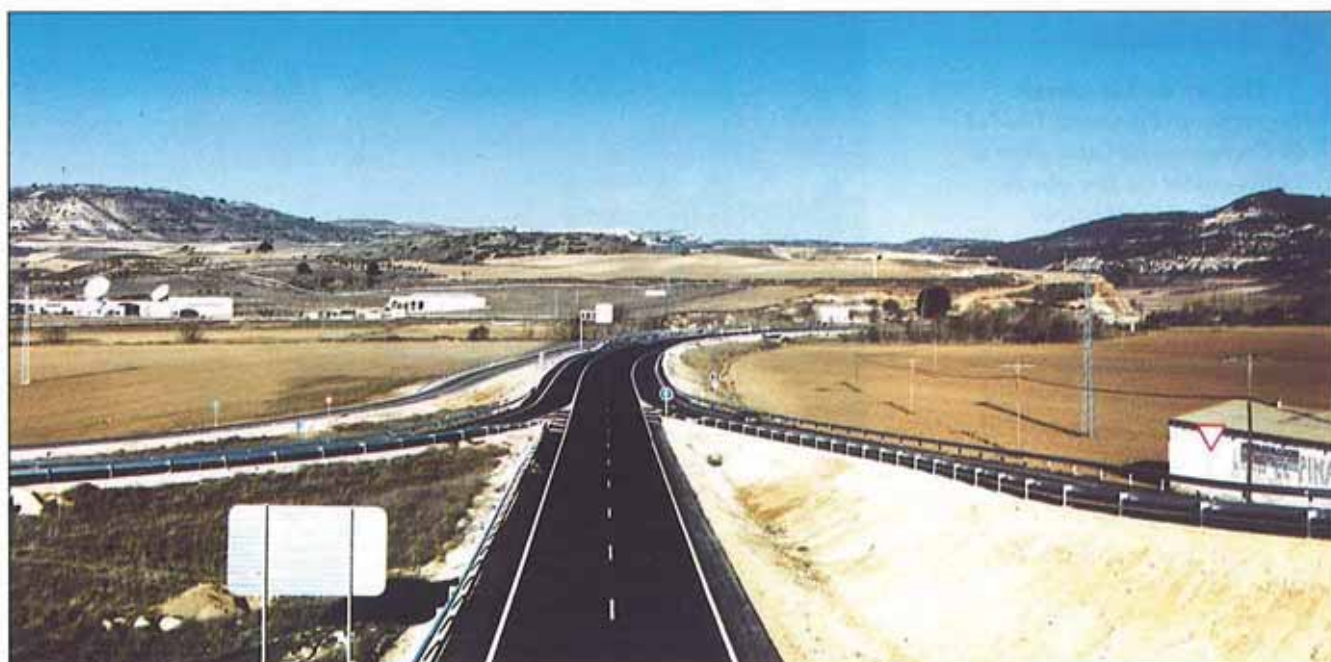
El tramo acondicionado tiene una longitud de 7 km.
