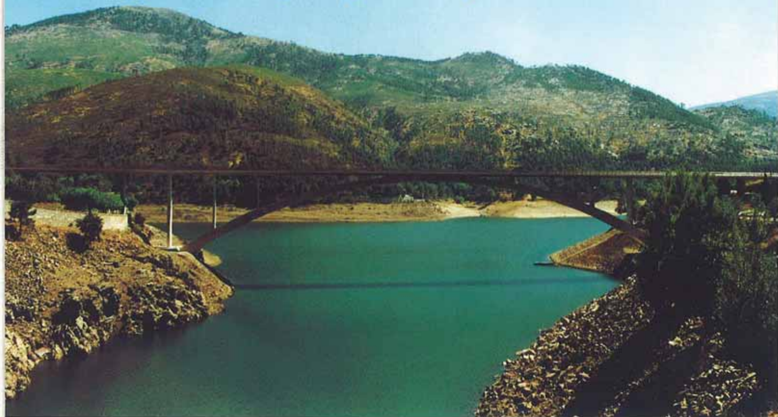
Puente arco sobre "Garganta Honda".
