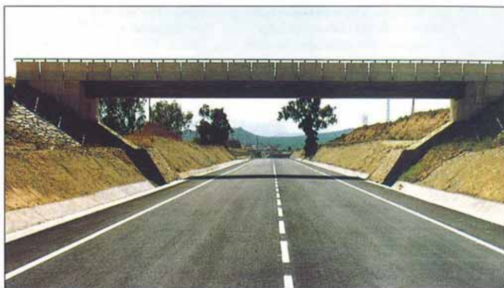
Paso superior en esta variante de 4,3 km de longitud.
