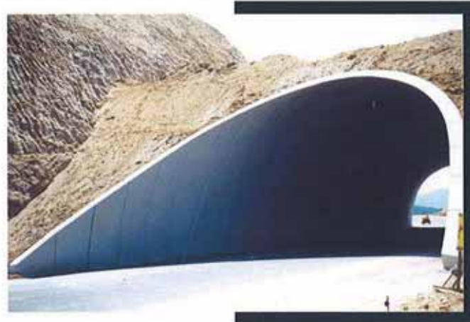
FALSO TUNEL (CON PICO DE FLAUTA) EJE TRANSVERSAL GIRONA-LLEIDA (ARBUCIES-CATALUNYA) G.I.S.A.
