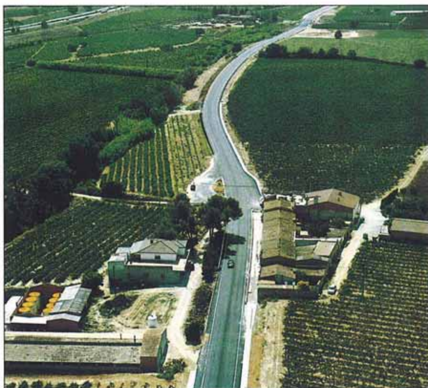
El tramo acondicionado tiene una longitud de 9,7 km.
