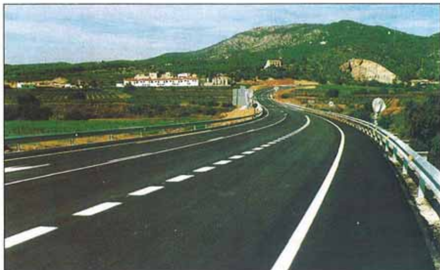
La variante tiene una longitud de 2 440 m y evita que el tráfico de la B-211 atraviese Sant Pere de Ribes.
