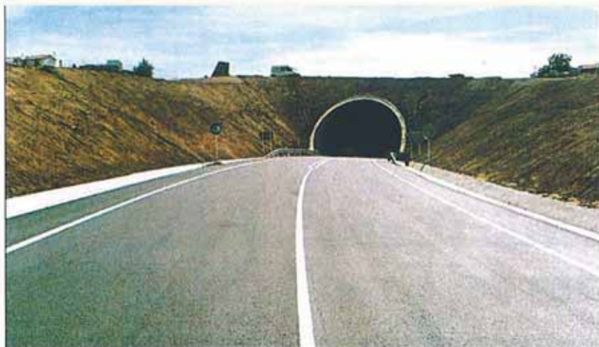
En la foto el falso túnel construido que tiene una longitud de 113 m.
