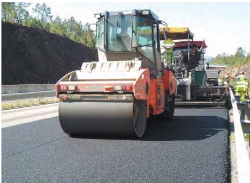
Foto 2. Detalle de la compactación de la mezcla con BBTFE; nótese la ausencia total de humos
