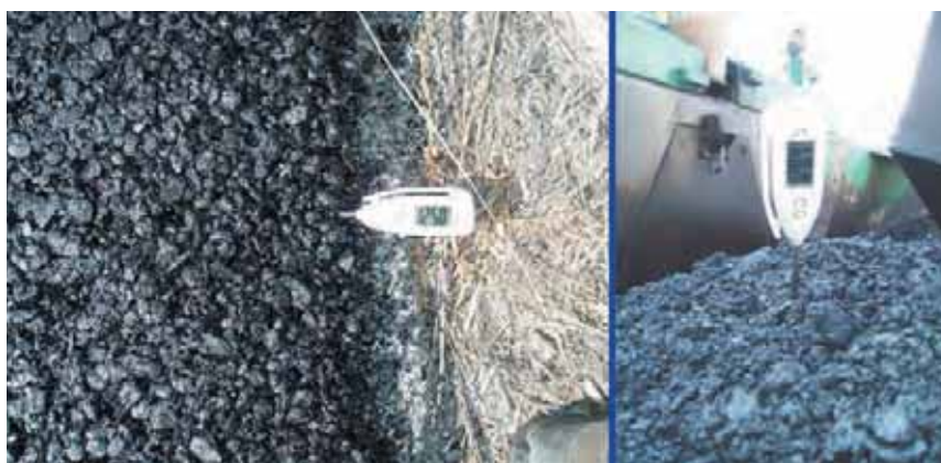
Foto 1. Medición de temperaturas en la mezcla
