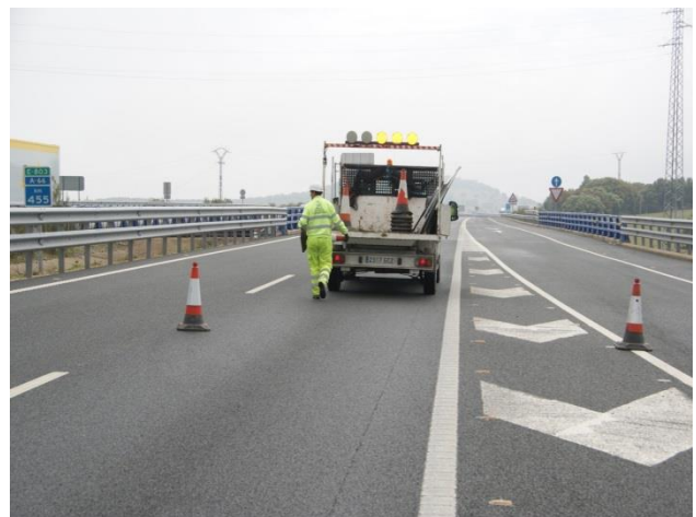
Figura 4. Colocación de conos a lo largo del corte
