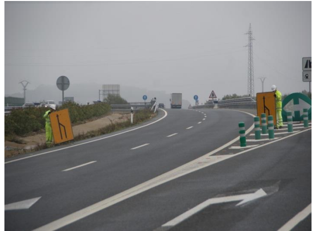
Figura 2. Colocación de señales cierre de carril (TS-54)
