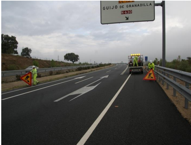
Figura 1. Colocación de señales de obra (TP-18)
