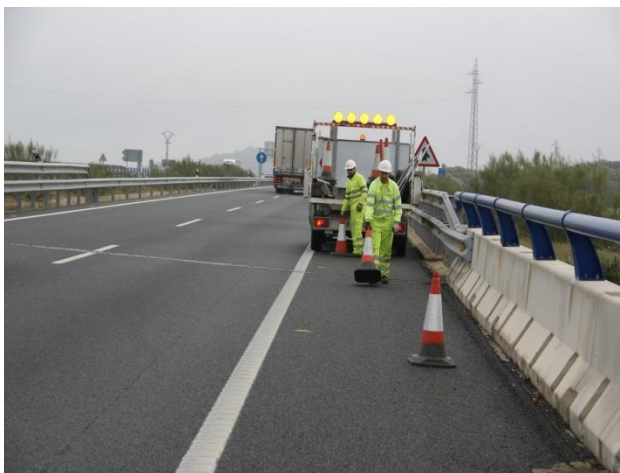
Figura 3. Disposición de conos al inicio de cuña de transición
