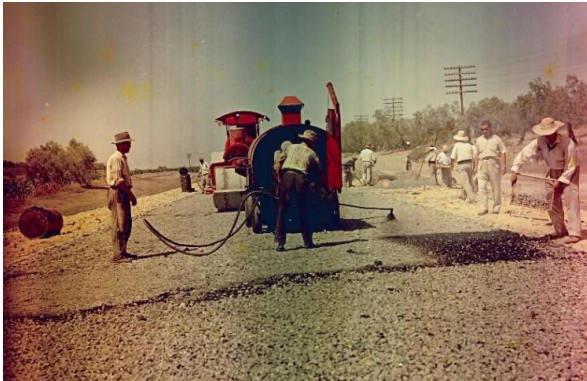
Figura 12.. Bituminadoras para la ejecución del riego asfáltico sobre bases granulares 12
