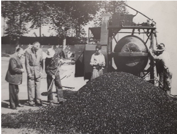
Figura 10. Fabricación de aglomerado en frío con hormigonera en el año 1951.
