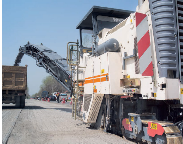
Figura 18. Fresadora de 2 metros de anchura de fresado
