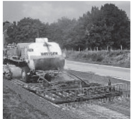
Figura 13. Primeras fresadoras en caliente. 1971 (izda) y 1973 (dcha)
