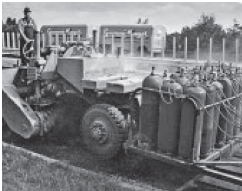
Figura 13. Primeras fresadoras en caliente. 1971 (izda) y 1973 (dcha)
