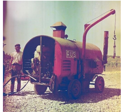
Figura 12.. Bituminadoras para la ejecución del riego asfáltico sobre bases granulares 12
