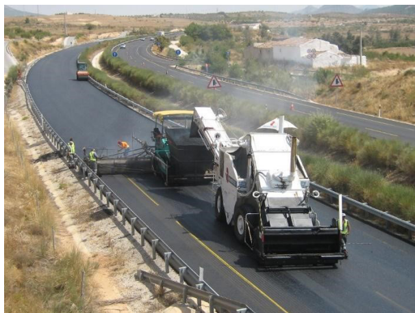
Figura 19. Extendido a ancho completo con empleo de silo de transferencia
