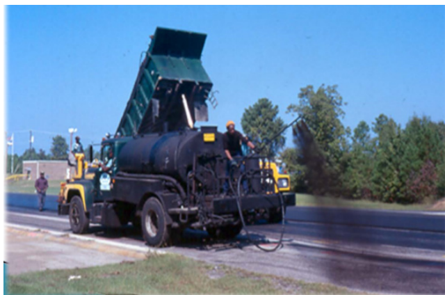
Figura 17: Aplicación del riego de adherencia mediante lanza Fuente: Blog Motores y carreteras
