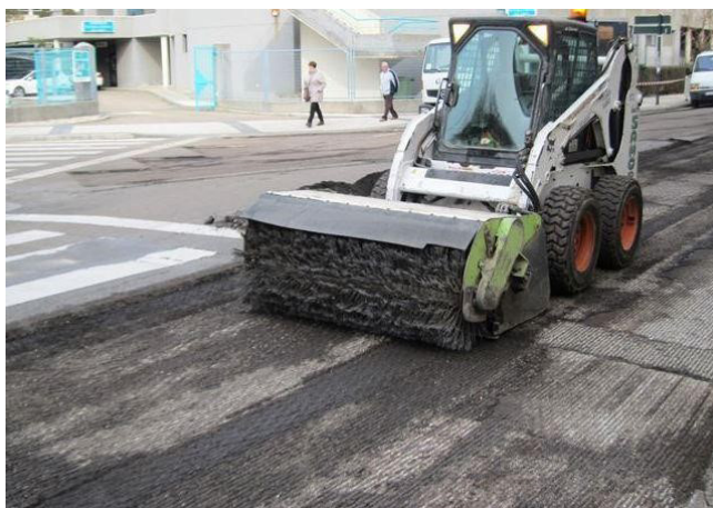
Figura 16. Minicargadora con implementación de equipo de barrido Fuente: Blog Motores y carreteras
