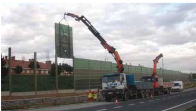
Instalación de apantallamiento acústico de 6,5 m de altura altamente absorbente en la M 50 de Madrid a su paso por Getafe (TECPRESA - FERROVIAL).
