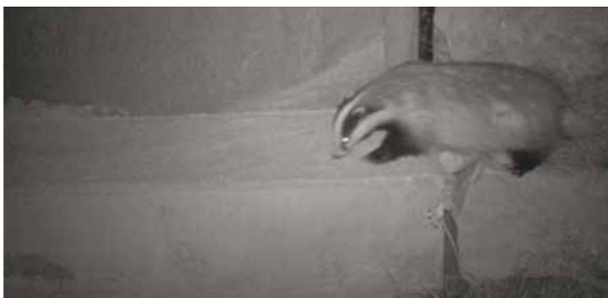
Tejón (*Meles meles*) atravesando la carretera NA-122 (Variante de Allo, Navarra), por un drenaje adaptado como paso de fauna. Se trata de un marco prefabricado de hormigón de 3 x 2 metros, con repisas secas de 0'5 metros de ancho (sobre la que se está desplazando el tejón).
