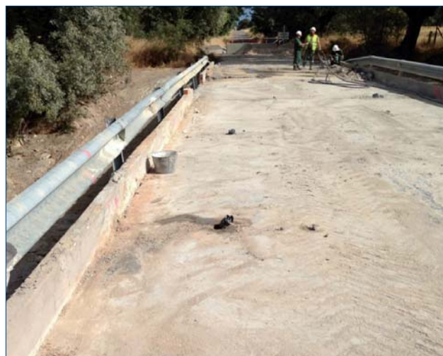
Muros laterales para la contención del detritus
