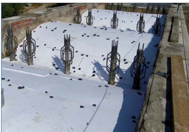
Colocación porexpan en arcos
