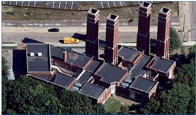
Figura 2. Estación de ventilación [Fuente: google 2014]
