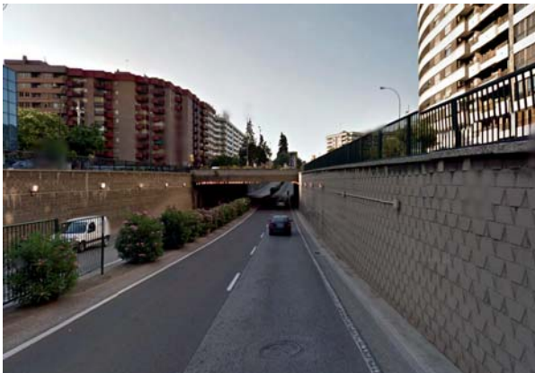
Túnel Avenida Cesáreo Alierta (ZARAGOZA)
