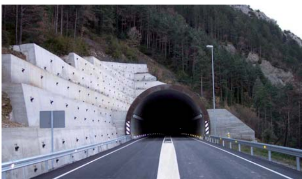
Túnel de Campo (HUESCA)
