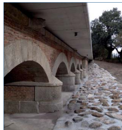
Solera de hormigón sobre escollera
