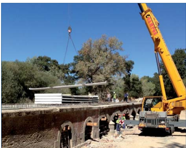
Colocación de prelosas
