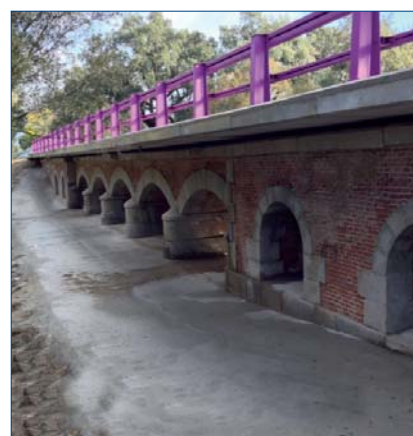
Solera de hormigón sobre escollera
