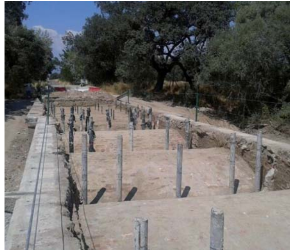
Vaciado timpanos de arcos
