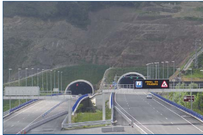
Figura 10. Túneles de la Variante Sur Metropolitana de Bilbao (España)
