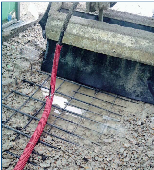
Figura 2. Detalle de armaduras intactas. Además el tablero no sufre vibraciones ni microfisuración
