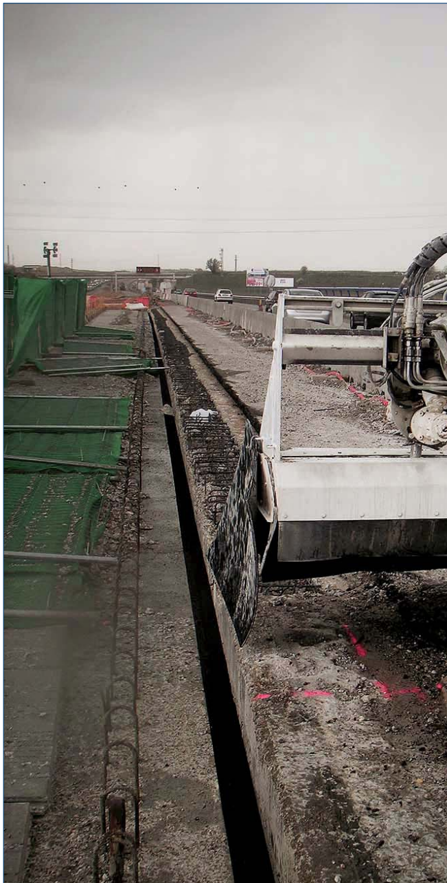
Figura 9. Equipo trabajando en una estructura en servicio
