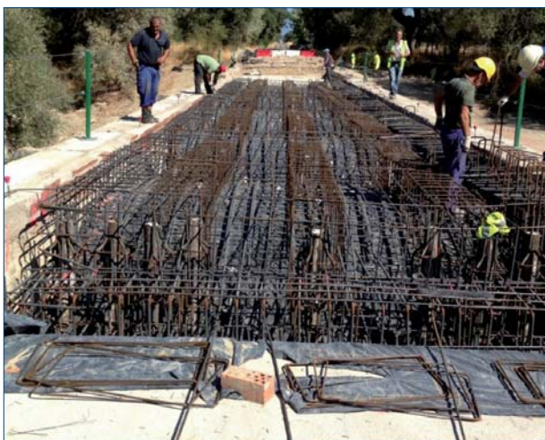
Colocación de armadura en vano central
