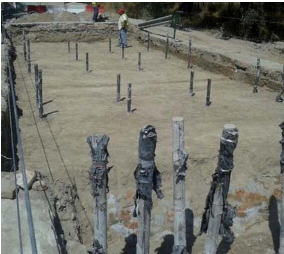
Vaciado timpanos de estribos
