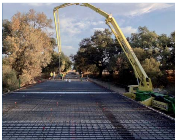
Armado y hormigonado de losas de compresión
