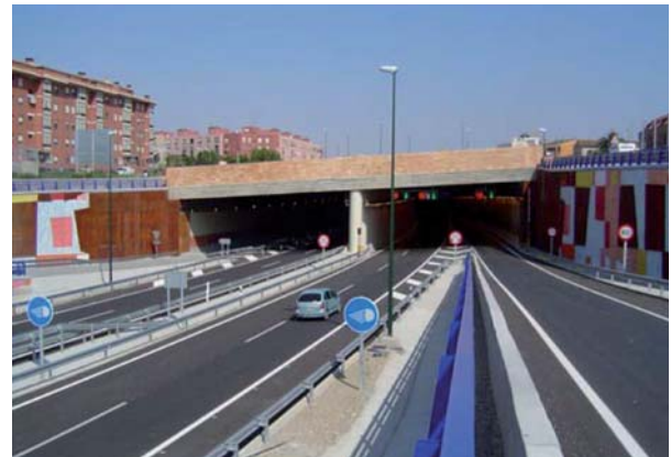
Túnel Ronda Este (Santa Isabel, ZARAGOZA)
