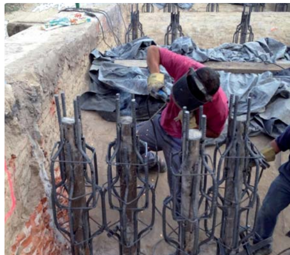
Colocación anclajes en cabeza de micropilotes
