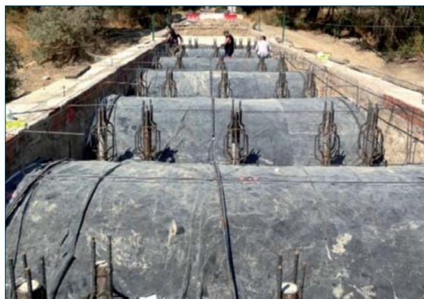
Colocación lámina de plástico
