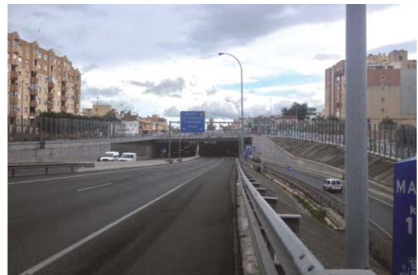
Túnel Ortega de Prados (MÁLAGA)
