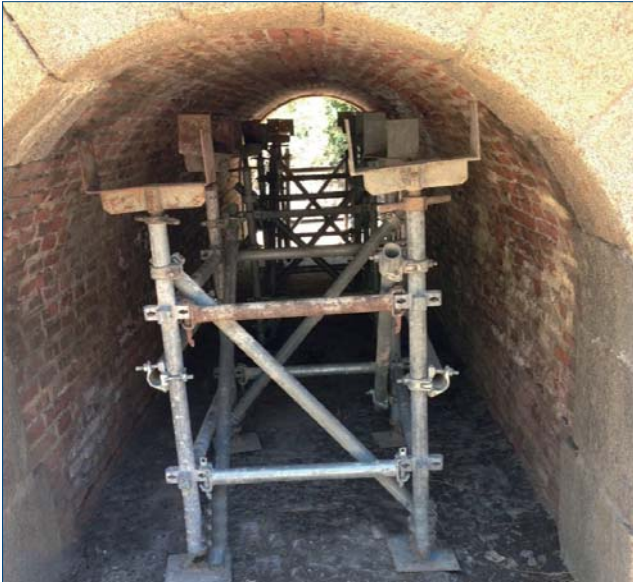
Cimbrado arcos laterales
