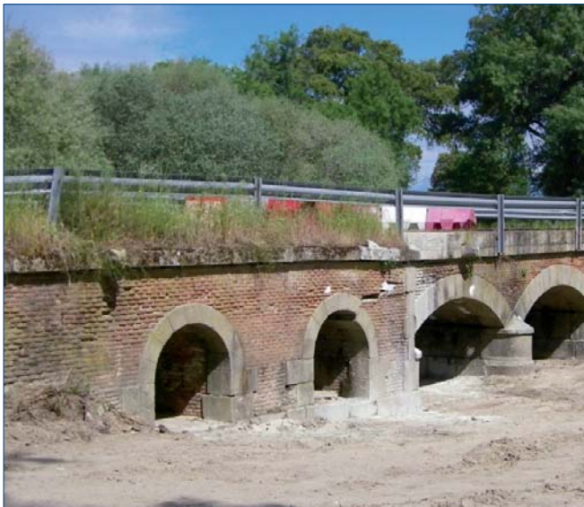
Vista inicial de la estructura aguas arriba
