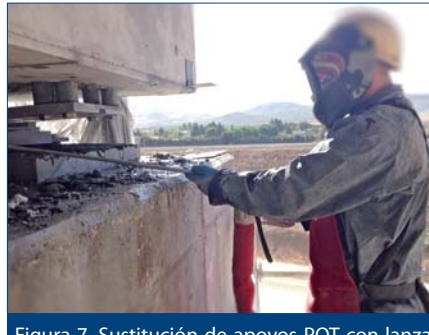
Figura 7. Sustitución de apoyos POT con lanza de hidrodemolición manual
