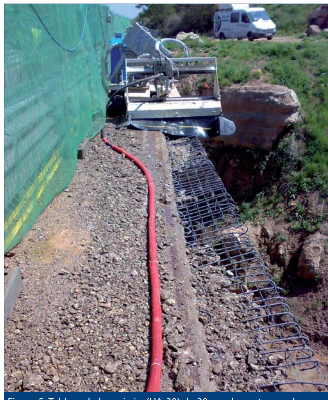
Figura 5. Tablero de hormigón (HA-30) de 30 cm de canto en el que se descubrieron las armaduras para su posterior ampliación
