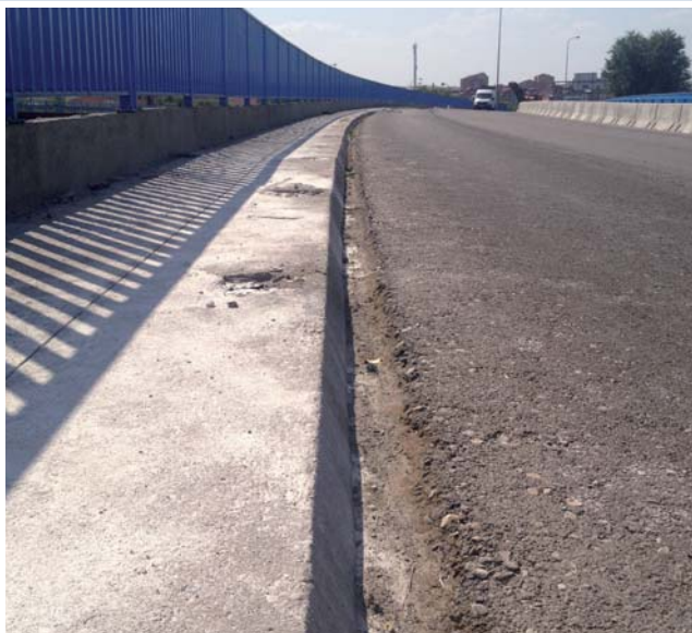
Estado inicial de la estructura
