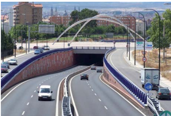
Túnel glorieta de la MAZ (ZARAGOZA)
