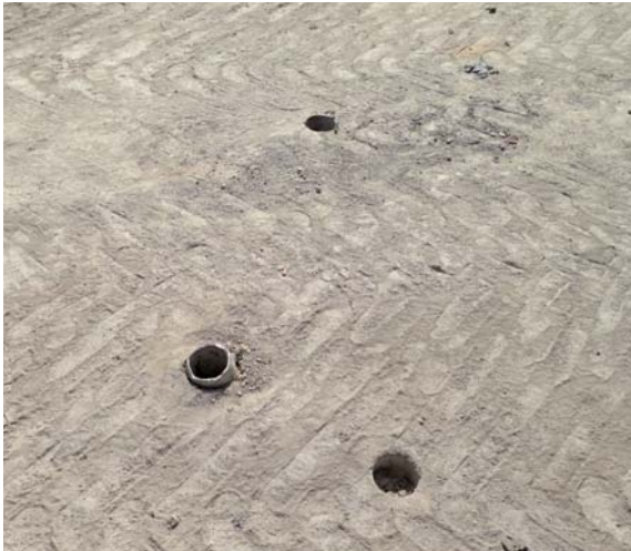
Detalle micropilotes en estribos
