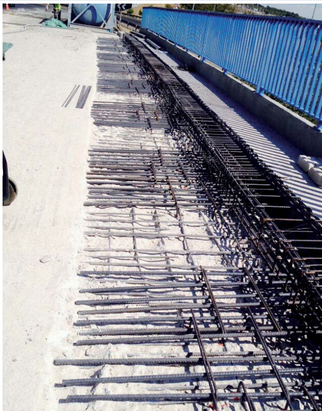
Detalle del nuevo zuncho instalado
