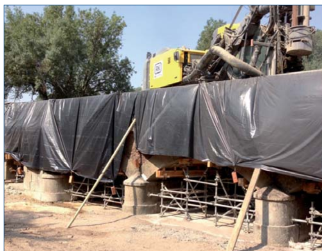
Protección de la estructura con plásticos
