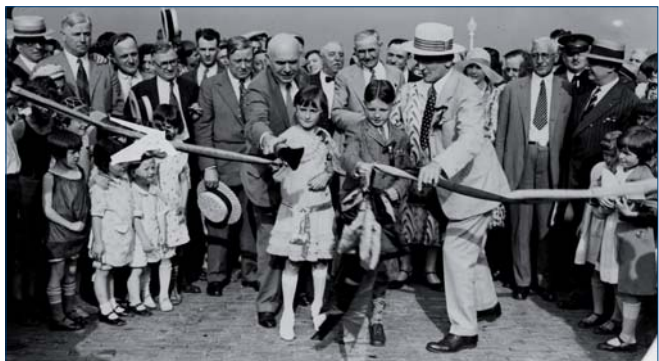
Figura 3. Inauguración del Liberty Tunnel (enero de 1924) [Fuente: Pittsburgh Post-Gazette]
