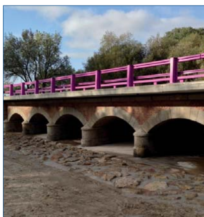
Escollera rejuntada con hormigón
