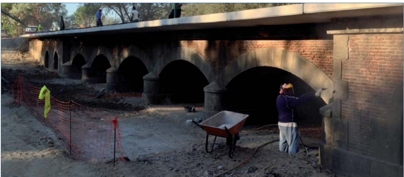
Limpieza con chorro de arena
