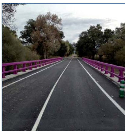
Extendido de aglomerado asfáltico
