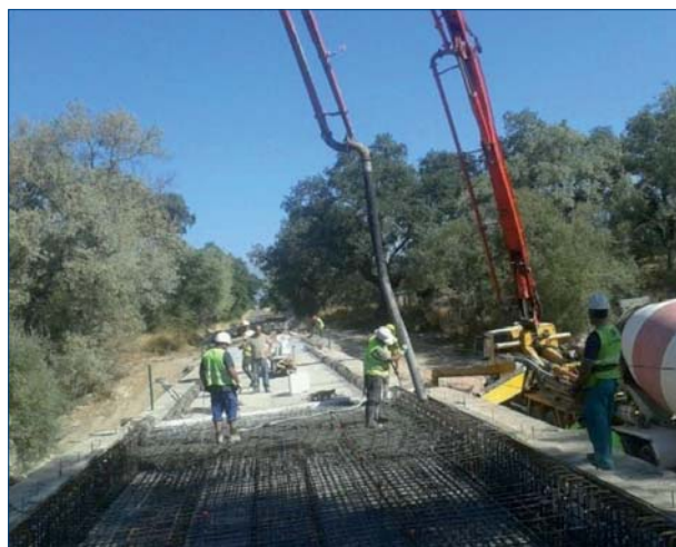
Hormigonado de estribo
