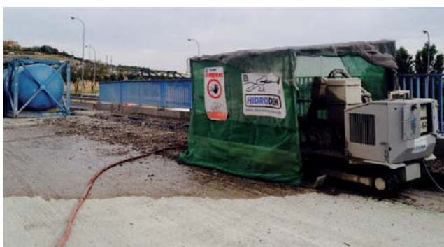
Hidrodemolición del borde del tablero
