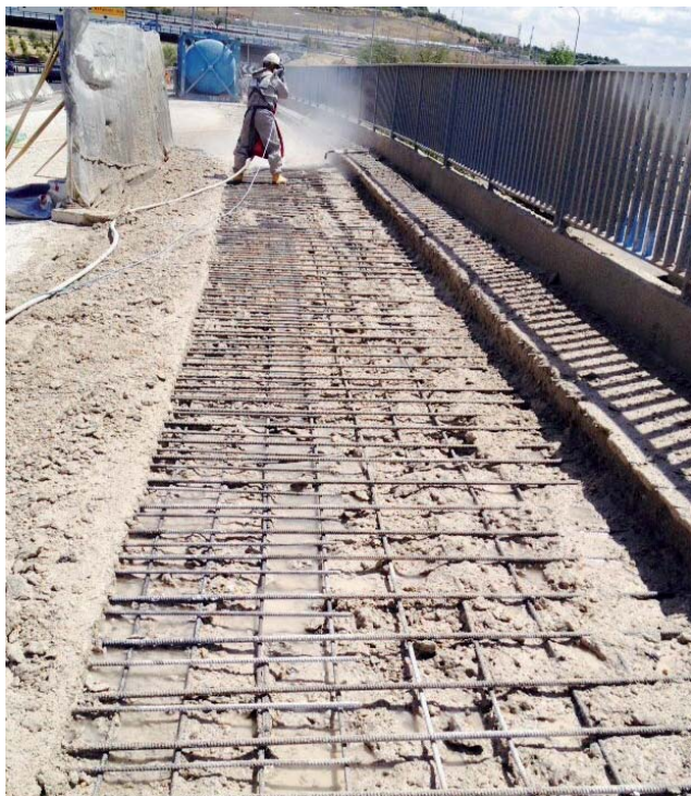
Acabados y remates con lanzas manuales en zonas más delicadas
