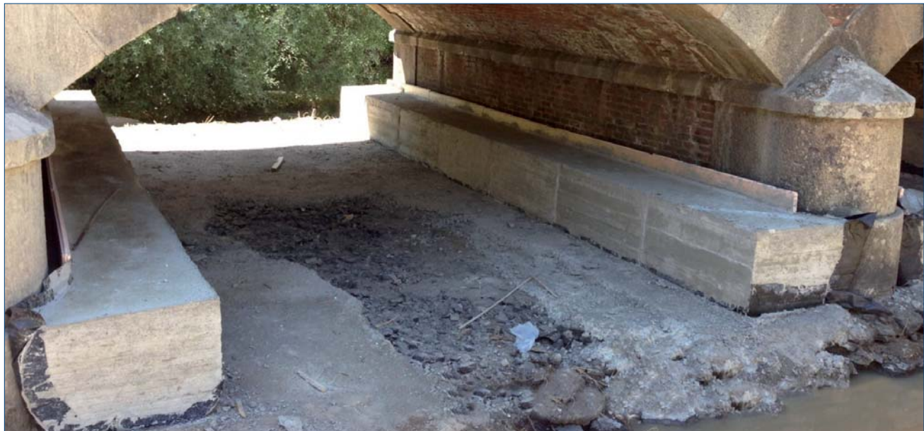
Detalle zapata de apoyo cimbra porticada
