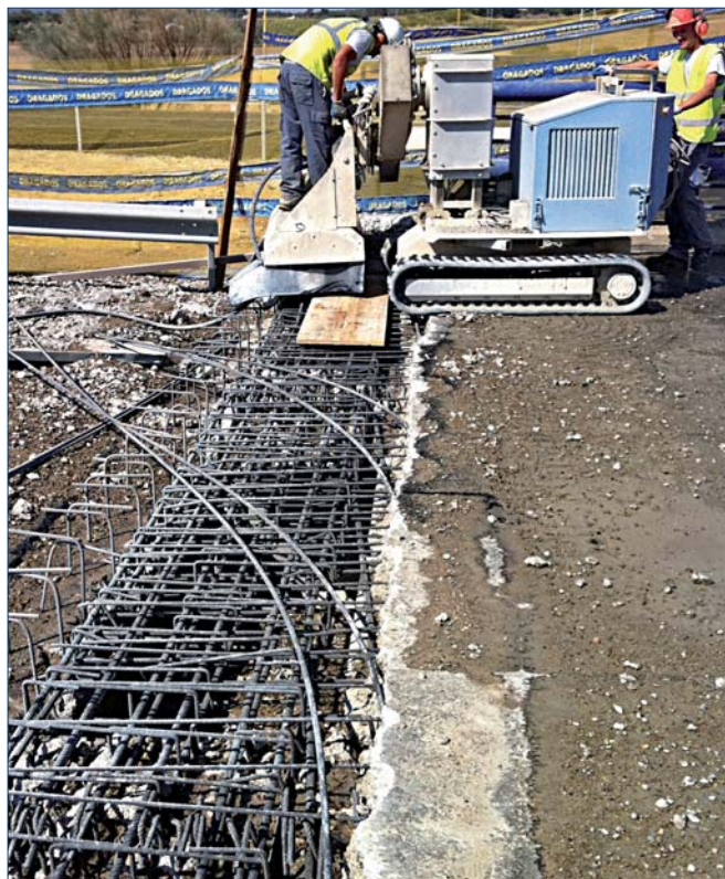
Figura 4. Preparación de una junta para su reparación
