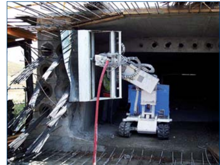
Figura 8. Rescate de elementos de tesado
