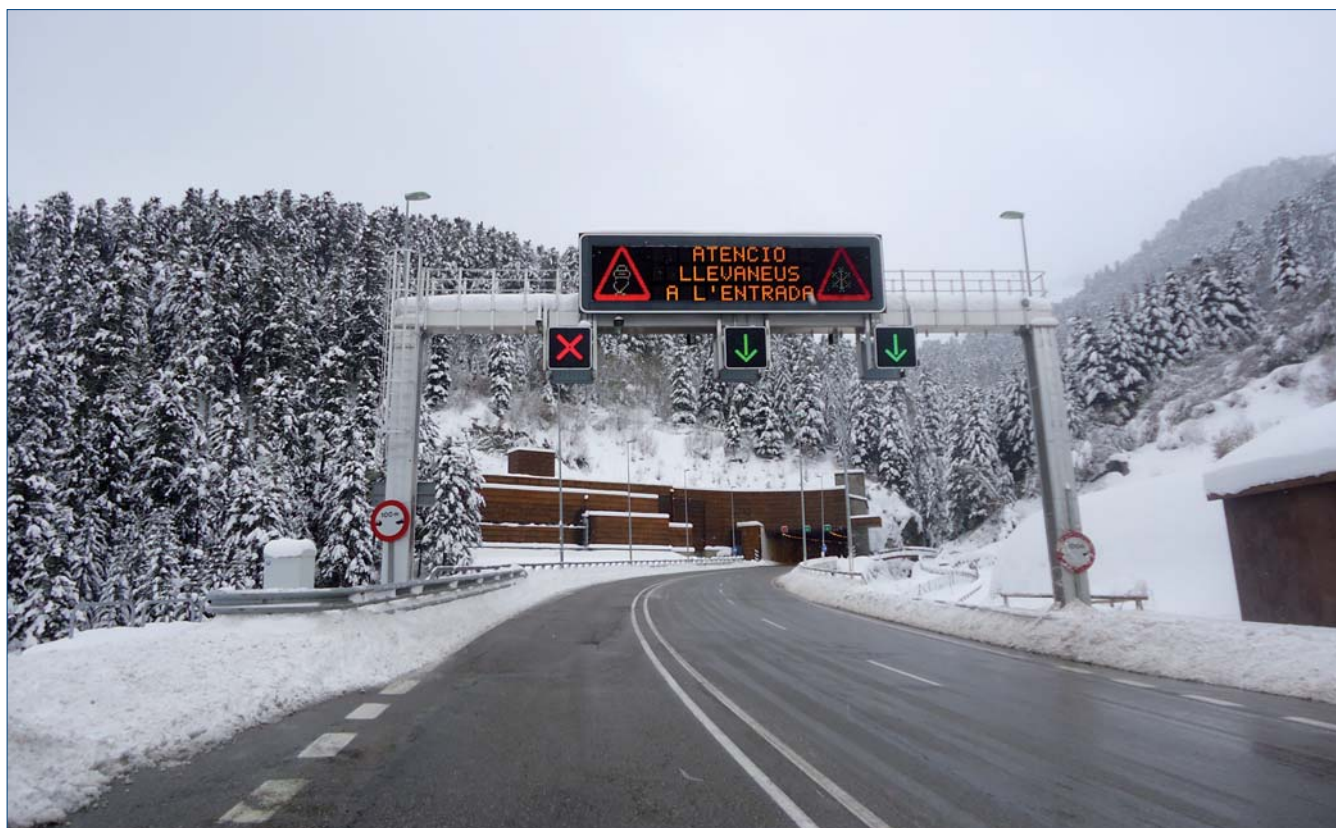
Figura 9. Túnel Juan Carlos I de Vielha
