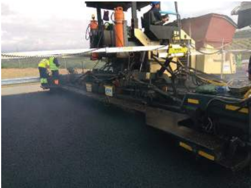
Figura 1. Extendido de la mezcla BBTM 11 B 35/50+RARX
