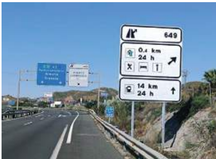
Figura 4. Instalación de un nuevo cartel de servicios en el enlace 649 de la autovía A-7, en la provincia de Murcia, diseñado conforme a la normativa vigente y en aplicación de los criterios establecidos en la OC 2/2024.
