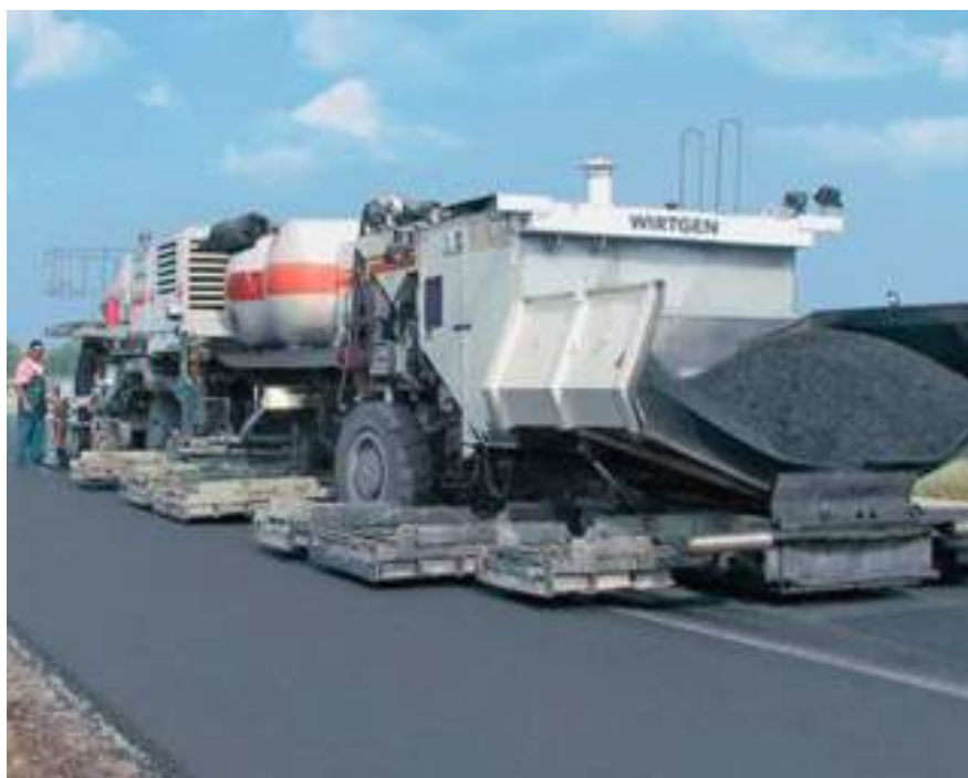
Figura 6. Reutilización en caliente in situ
