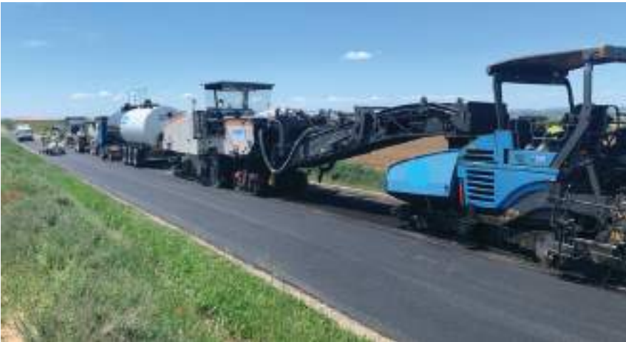
Figura 9. Reutilización in situ en frío con emulsión
