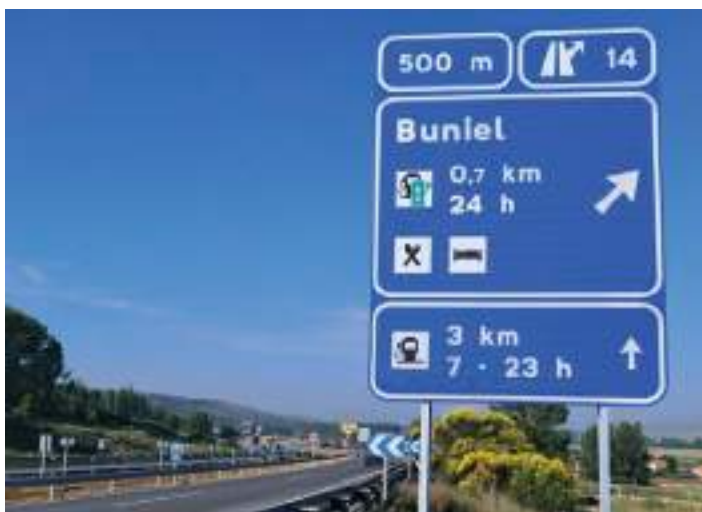
Figura 5. Instalación de un nuevo cartel de preaviso de servicios en el enlace 14 de la autovía A-62, en la provincia de Burgos, diseñado conforme a la normativa vigentes y en aplicación de los criterios establecidos en la OC 2/2024.
