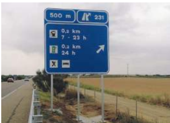
Figura 6. Instalación de un nuevo cartel de preaviso de servicios en el enlace 231 de la autovía A-6, en la provincia de Valladolid, diseñado conforme a la normativa vigentes y en aplicación de los criterios establecidos en la OC 2/2024.
