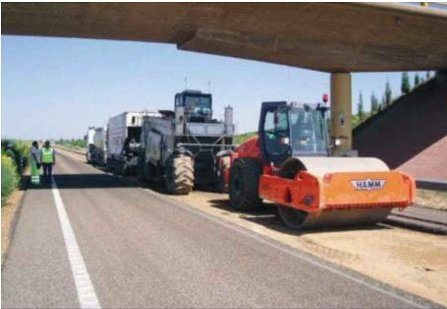
Figura 7. Reutilización in situ con cemento
