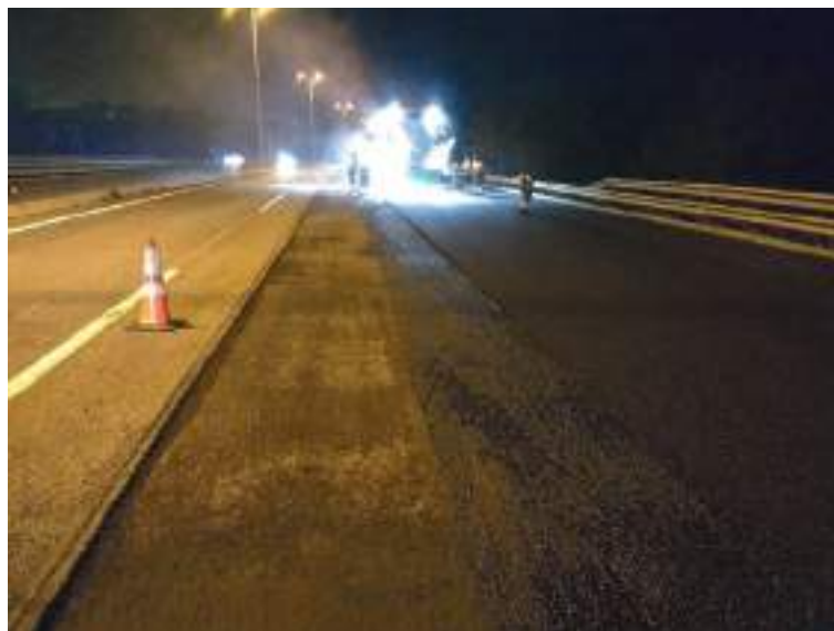
Figura 12. Extendido de la mezcla SMA 11 en la AP-7
