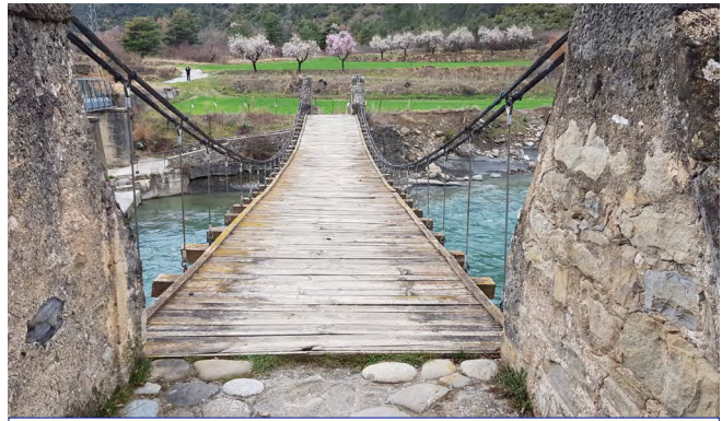
Fotografía 2. Detalle del sistema de suspensión del tablero
