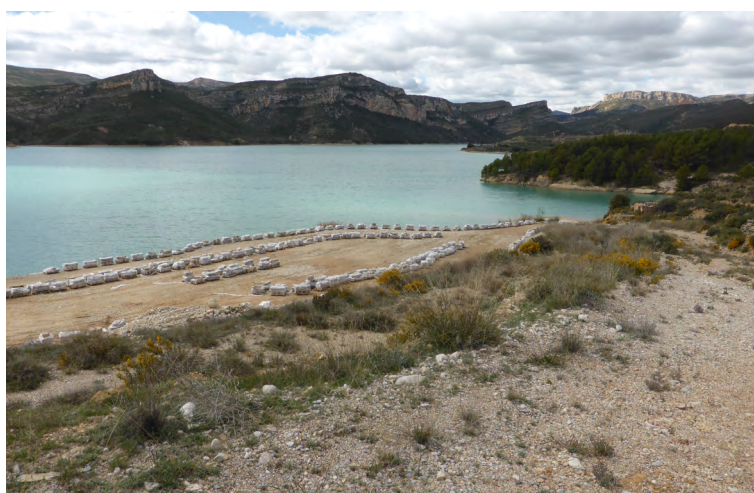
Fotografía 12. Explanada con los acopios de dovelas
