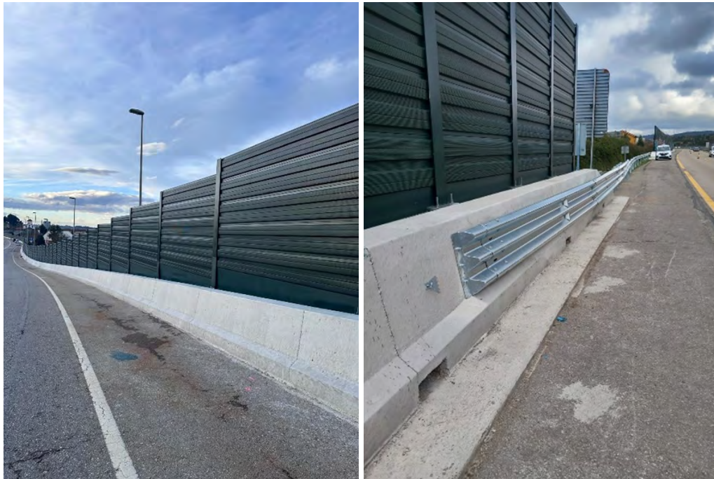
Fotos 13 y 14. Instalación de sistema integrado
