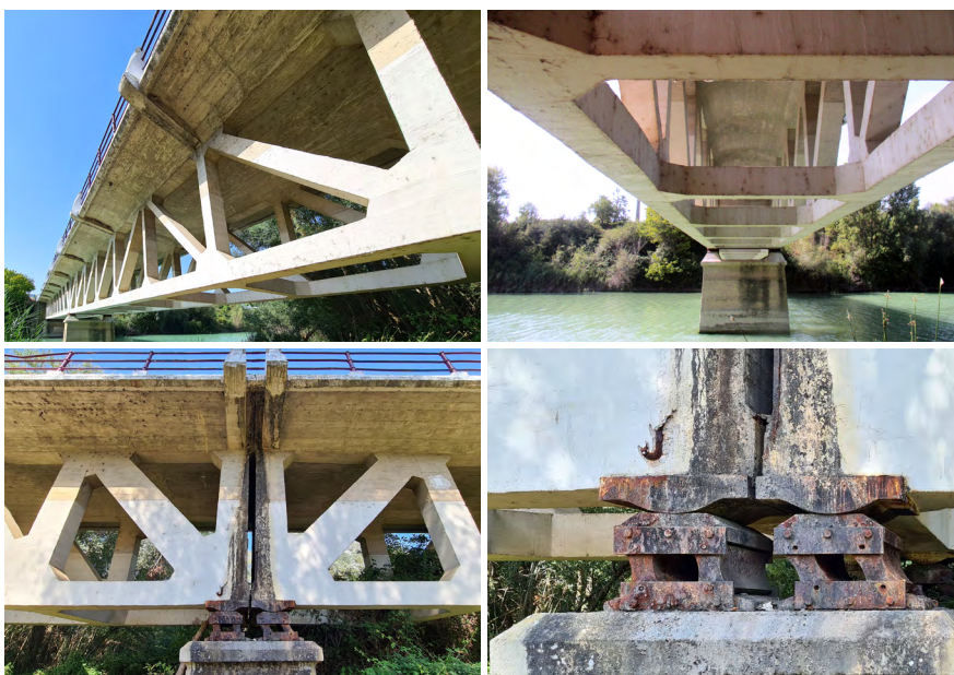
Fotografía 9. Detalles del tablero y apoyos
