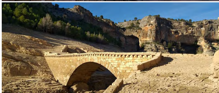
Fotografía 11. Dos vistas del puente, después del desembalse por la construcción de la tercera presa de Santolea
