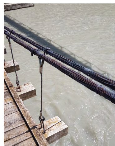
Fotografía 4. Elementos de suspensión de las péndolas. Pasarela de Santaliestra
