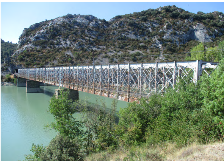
Fotografía 15. Vista general del puente desde el lado derecho de salida
