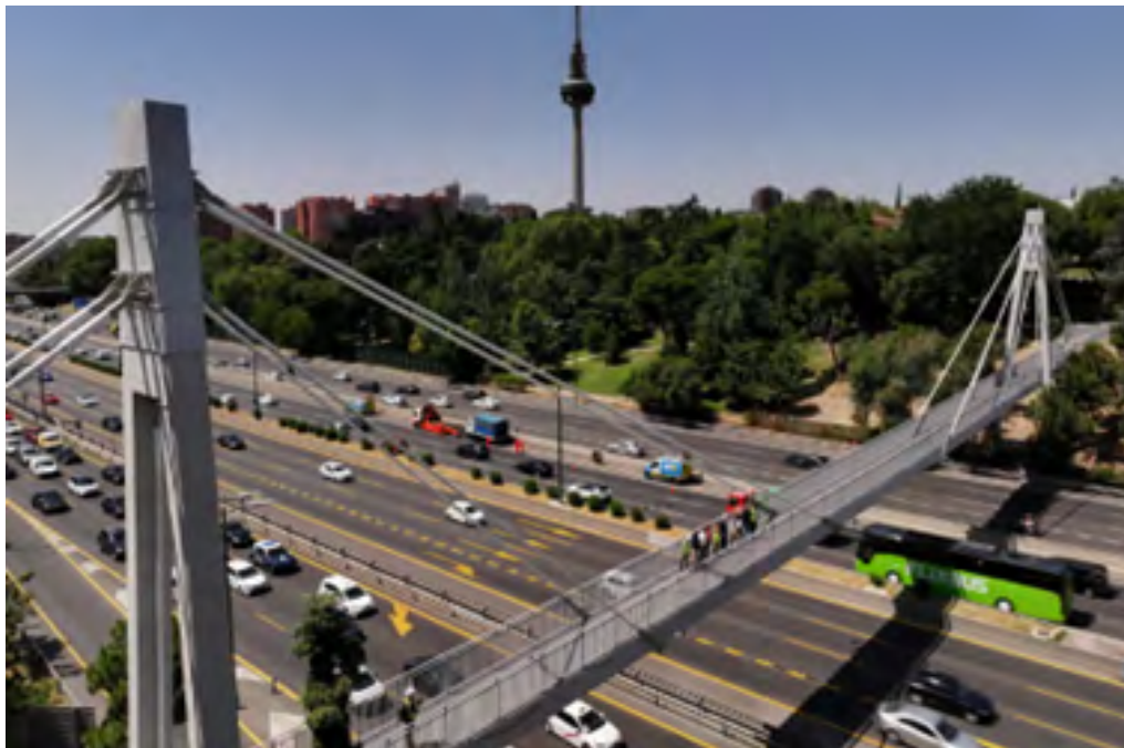
Figura 5. Obra de rehabilitación de estructuras con apoyos a media madera
