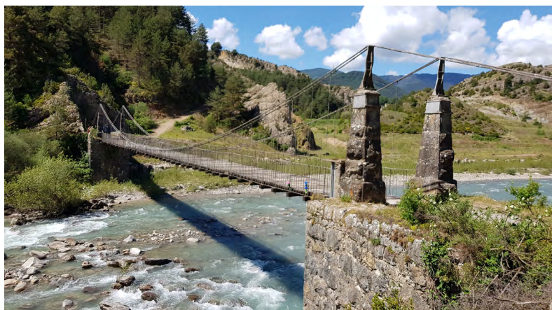
Fotografía 5. Aspecto actual del puente
