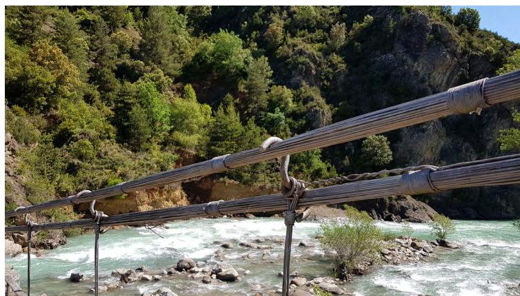
Fotografía 7. Detalle del sistema de suspensión con cables de alambres paralelos
