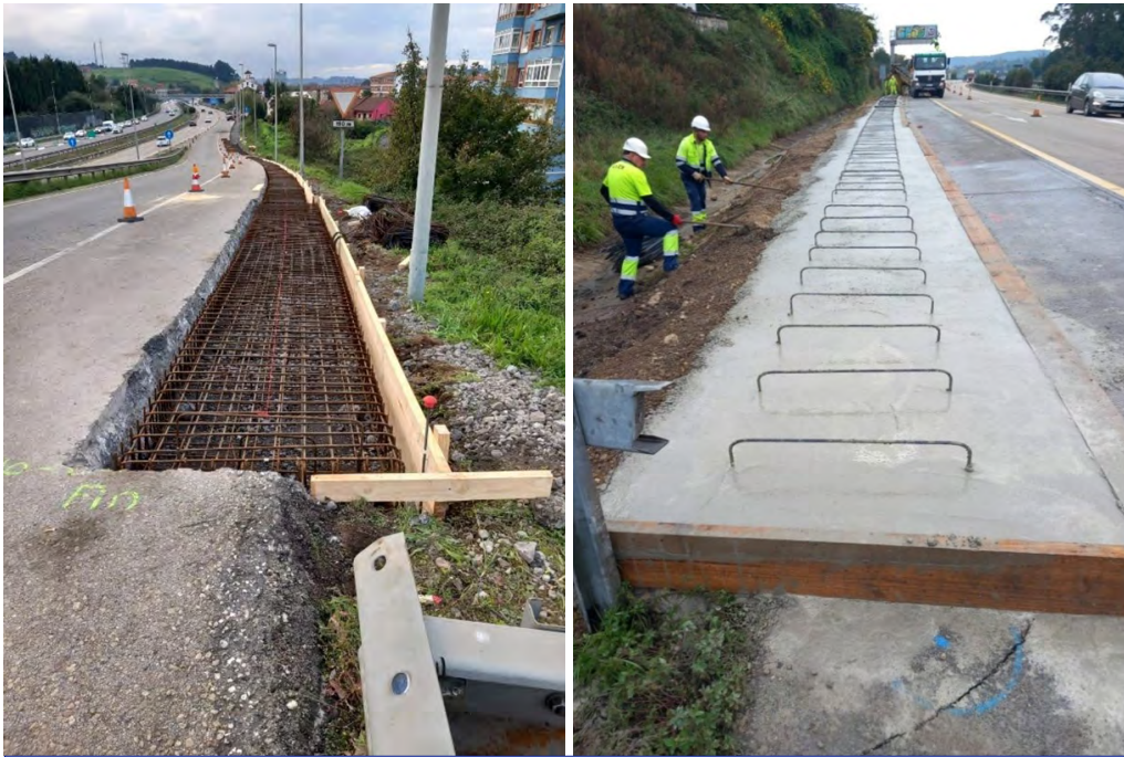
Fotos 9 y 10. Instalación de sistema integrado
