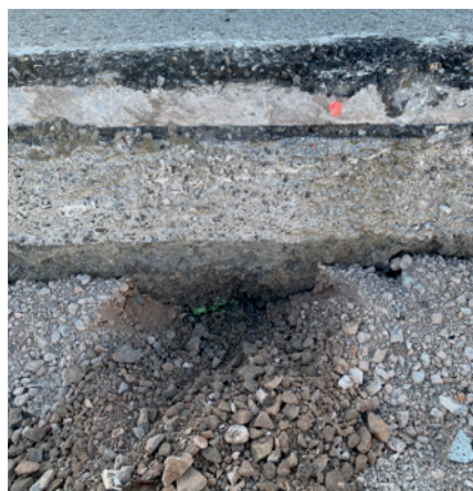
Figura 3. Diferentes capas localizadas en el firme y explanada existente.
