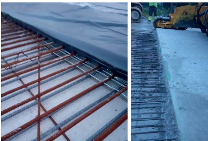
Figura 18. Ejecución de junta de trabajo en hormigón HF-4,5.
