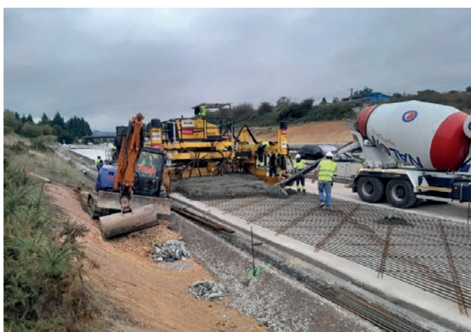
Figura 14. Extendido de capa de hormigón HF 4,5 (ii).
