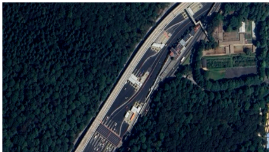
Figura 1. Perspectiva aérea de la autopista México – Toluca
