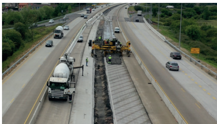
Figura 17. Tren de extendido de hormigón, vertido con autobomba, HF-4,5.
