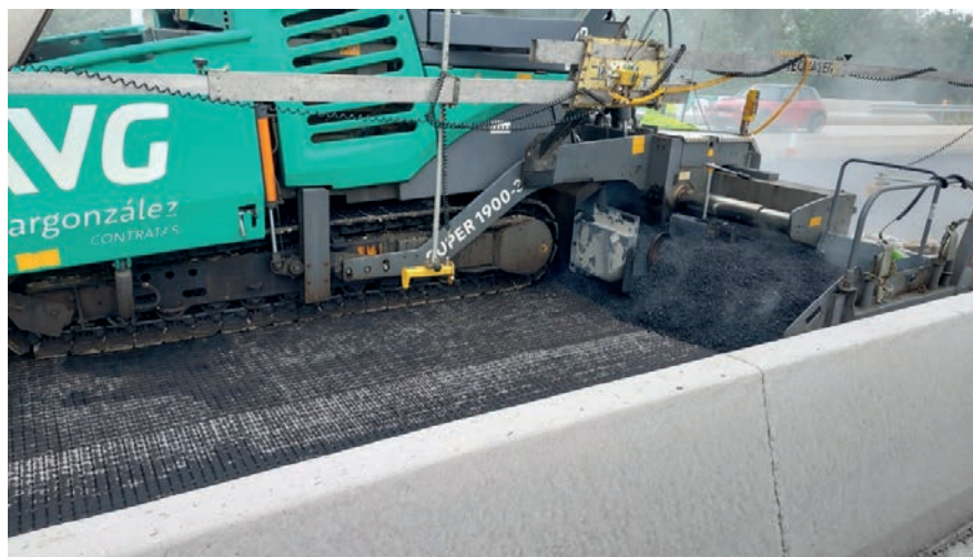
Figura 22. Extendido de capa AC-16 sobre geocompuesto.
