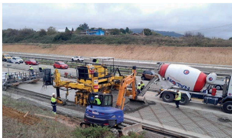
Figura 16. Tren de extendido de hormigón, vertido con canaleta, HF-4,5.
