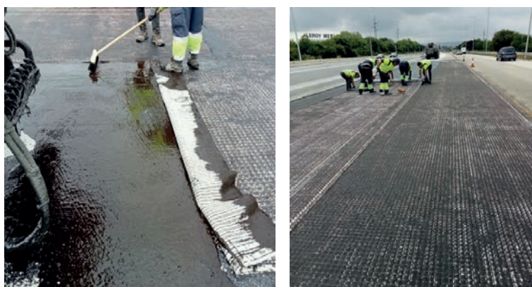
Figura 21. Solape transversal y longitudinal del geocompuesto.
