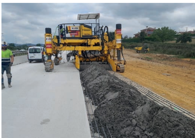
Figura 13. Extendido de capa de hormigón HF 4,5 (i).
